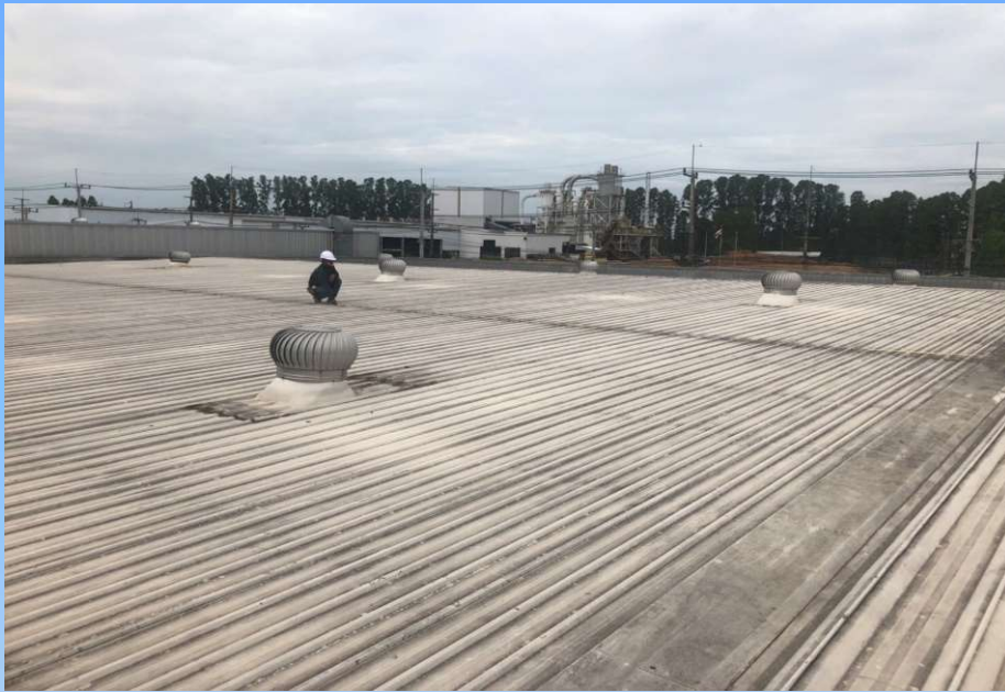
- รูปก่อนเปลี่ยนหลังคา
